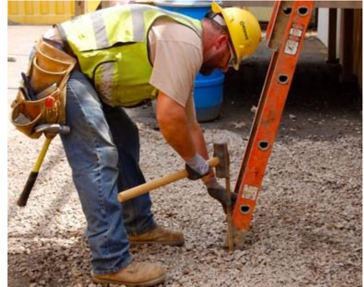
Poniendo estacas y asegurando los rieles laterales de una escalera para prevenir caídas. Imagen: Kiewit Power Constructors/eLCOSH.org
