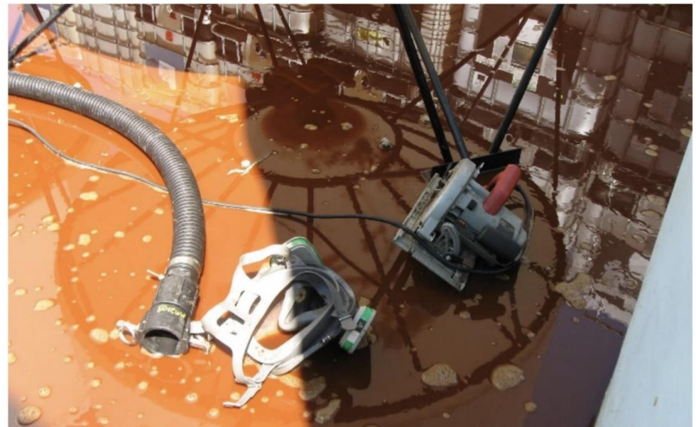
El fondo del tanque donde quedaron la sierra circular y el respirador del trabajador.
