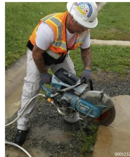
Un trabajador de la construcción usando una sierra eléctrica portátil con un sistema de entrega de agua integrado.
