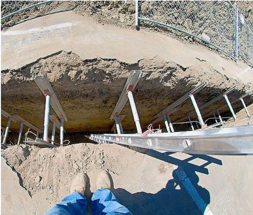
Ejemplo de estar sobre un sistema de apuntalamiento hidráulico. (*4)
