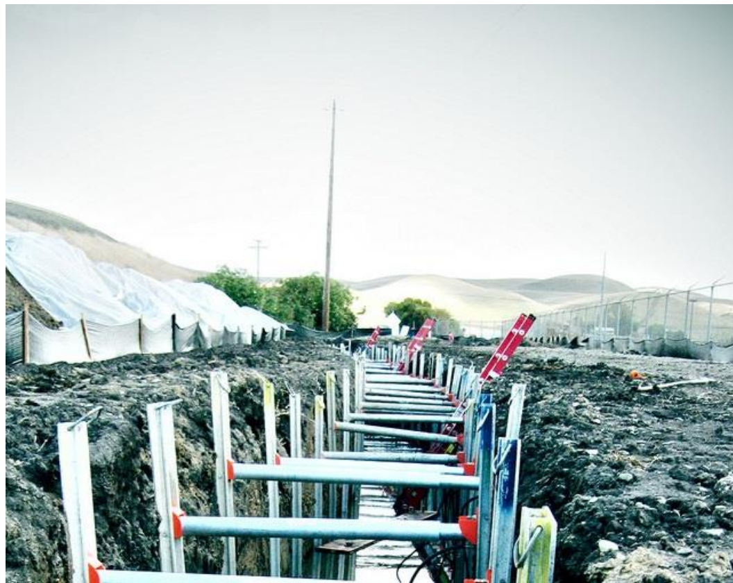
Sistema de apuntalamiento hidráulico instalado en esta zanja larga. Nota que las escaleras están colocadas a menos de 25' de distancia y se extienden a más de 3' del lado de la excavación como lo requieren las regulaciones OSHA. (*7)
