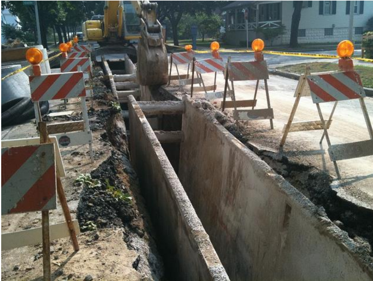
Ejemplo de cajas para zanjas colocadas dentro de esta excavación. Nota que la escalera no está colocada para la entrada segura al momento que la foto fue tomada. (*6)
