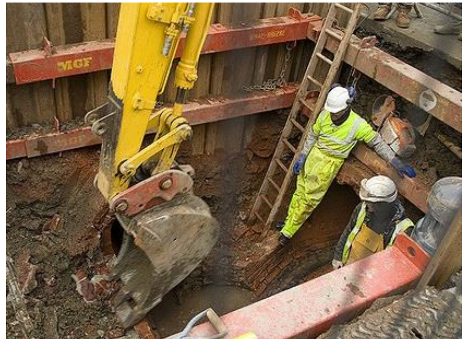
Ejemplo de trabajadores dentro de un sistema de apuntalamiento de madera. (*5)
